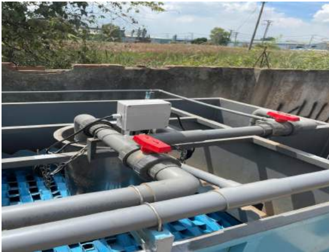
Hình 3.7. Hệ thống xử lý nước thải, công suất 40 m 3 /ngày đêm
