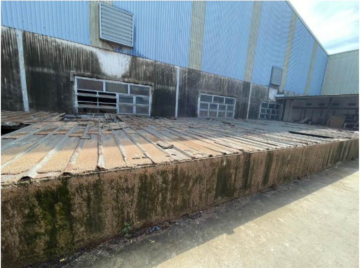
Hình 3.20. Một số hình ảnh về biện pháp PCCC tại cơ sở
