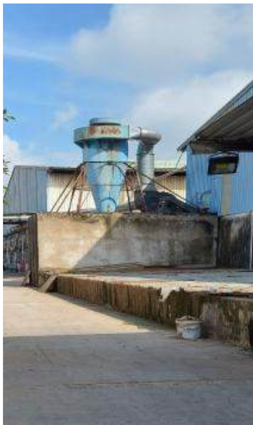
Hình 3.9. Hệ thống lọc bụi cyclone
