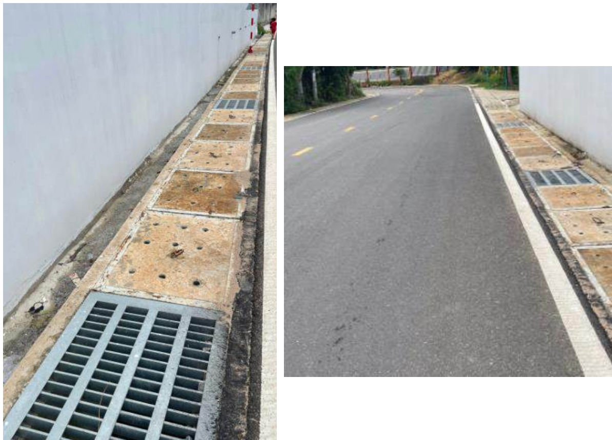
Hình 2. 3: Mương thoát nước của khu vực trên đường DX2
