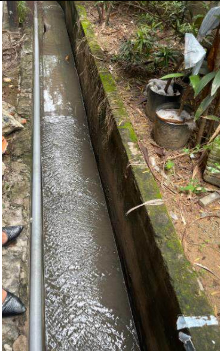
Hình 2. 2: Mương thoát nước khu vực bên trong nhà máy
