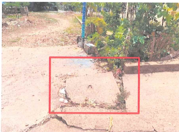
Hình 3.4. Hố ga đầu nối thoát nước thải
