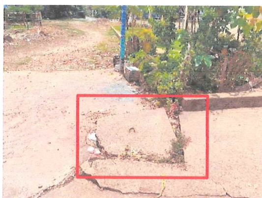
Hố ga đầu nối thoát nước mưa
