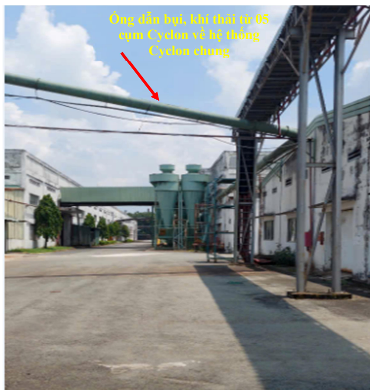
Hình 4.10. Cụm hệ thống Cyclon thu bụi tại nhà máy
