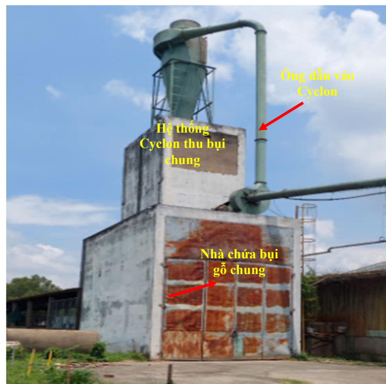
Hình 4.10. Cụm hệ thống Cyclon thu bụi tại nhà máy
