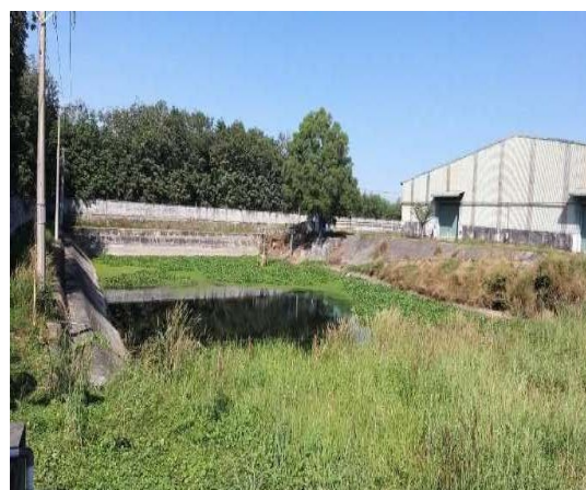
Hồ chứa nước mưa 8.000 m 3
