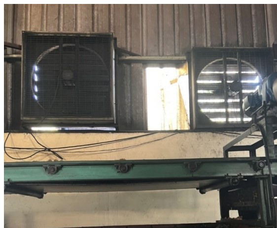
Hình 3.9. Hệ thống quạt thống gió đã lắp đặt tại Nhà máy
