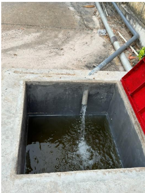
Hồ ga thu gom nước thải nội bộ của cơ sở
