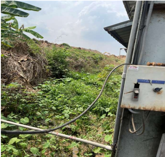
Mương đất thu gom và thoát nước khu vực bãi đất sét
