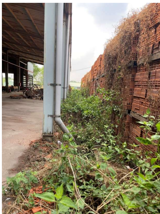
Hệ thống thu gom và thoát nước khu vực nhà xưởng
