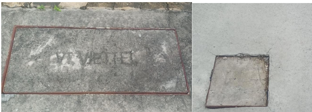
Hình 1. 9. Hệ thống thông tin liên lạc tại khu quy hoạch
