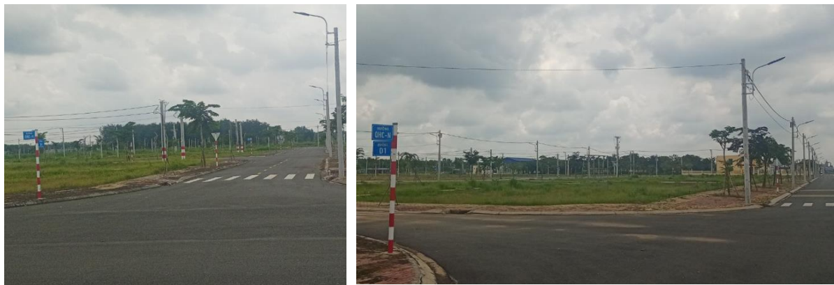
Hình 1. 6. Đường giao thông nội bộ tại khu vực dự án
