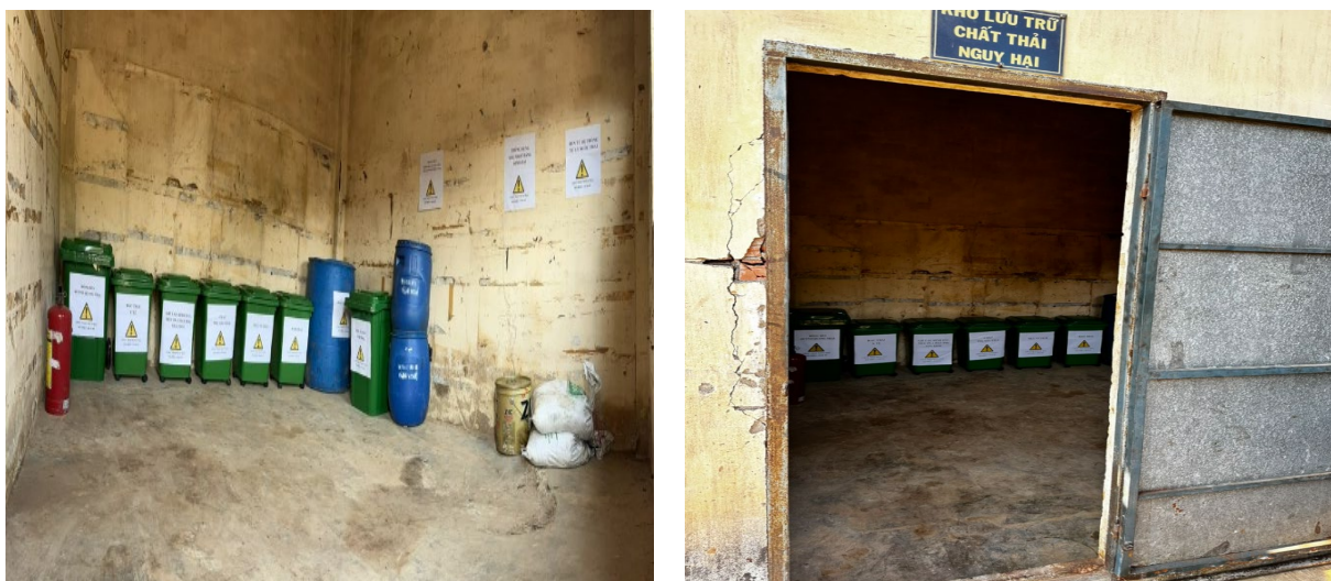
Hình 3. 91. Nhà chứa chất thải nguy hại
