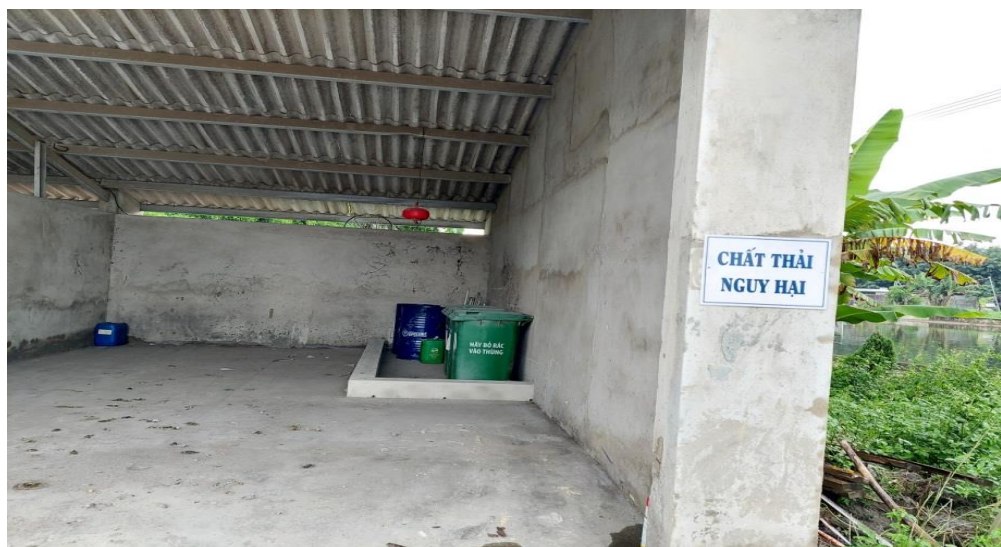
Hình 3. 11. Nhà chứa chất thải nguy hại
