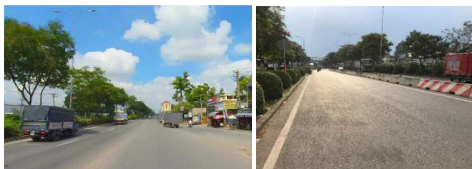
Hình 1. 5. Quốc lộ 1A đoạn cách 150m khu đất dự án
