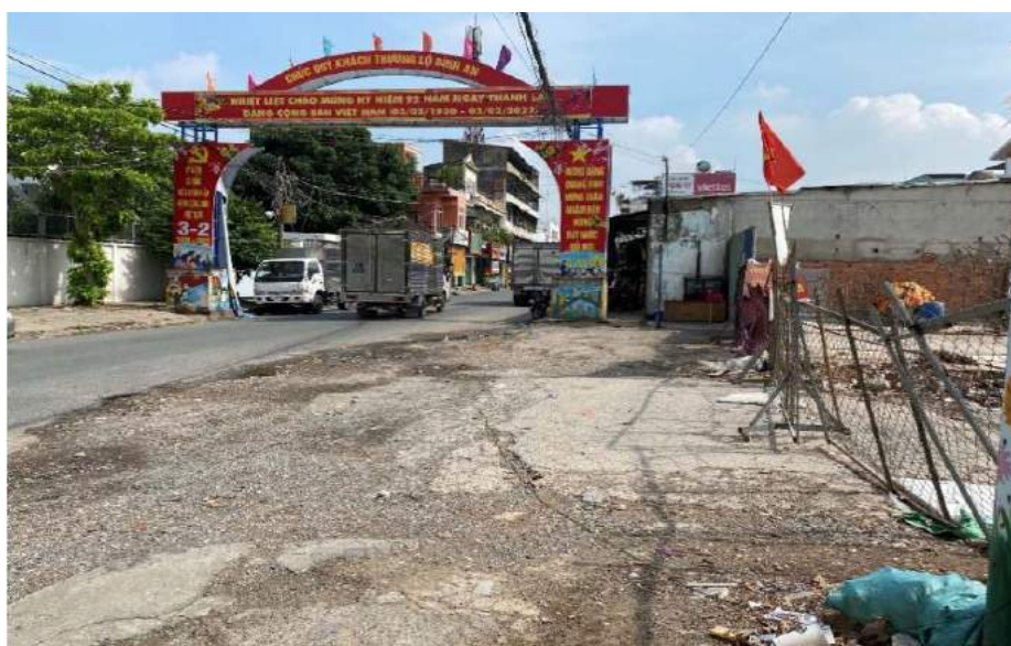
Hình 1. 4. Đường Lê Trọng Tấn đoạn đi qua trước khu đất dự án (Khu vực dự án là khu vực có hàng rào lưới).
