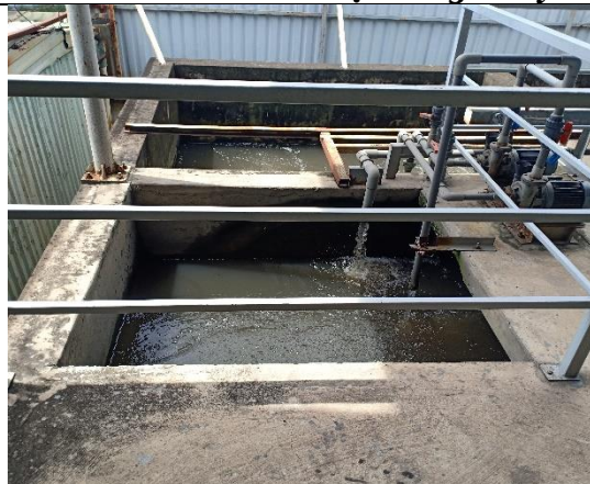
Hình 3.11. Hệ thống xử lý nước thải tập trung tại nhà máy
