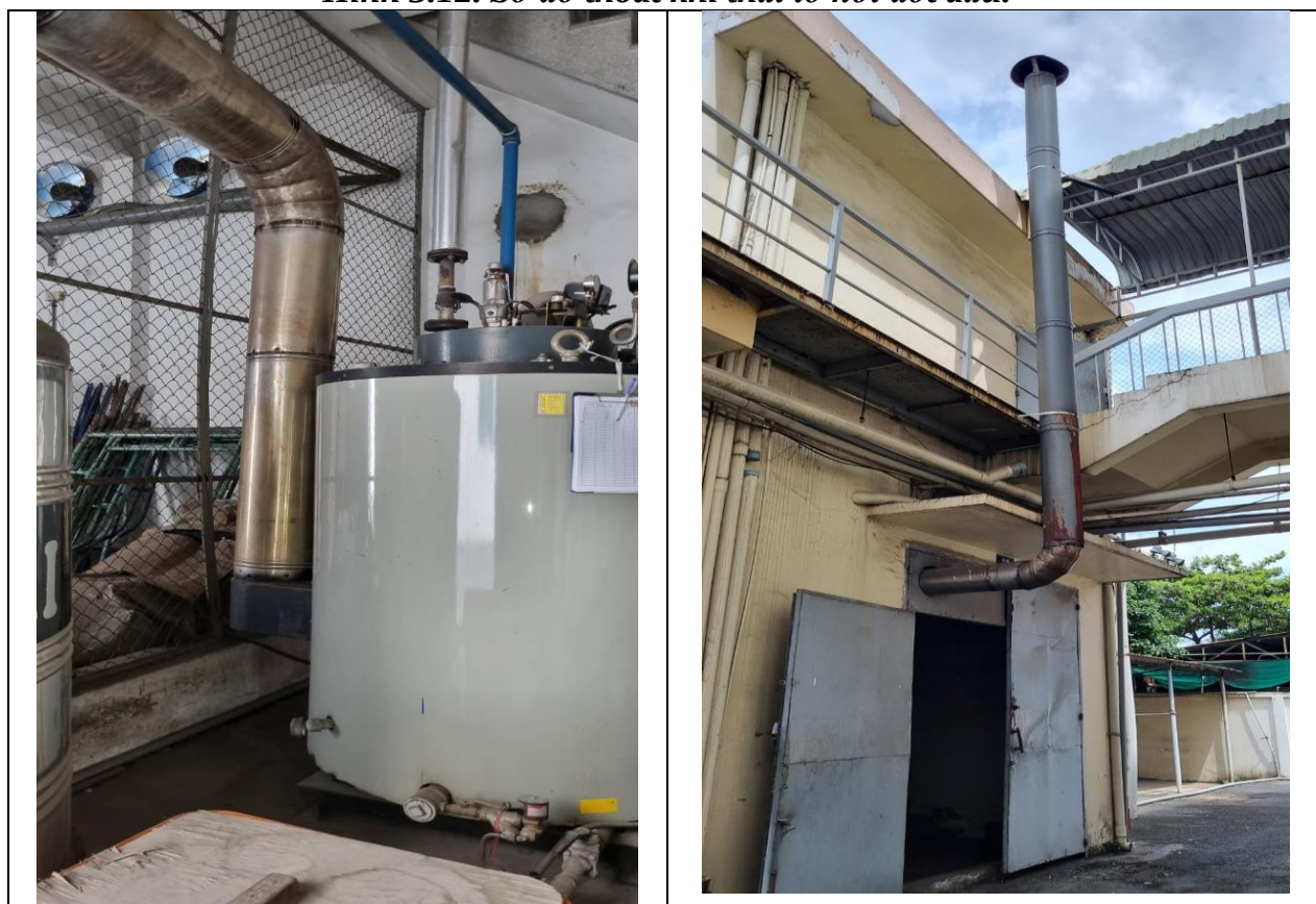
Hình 3.13. Hệ thống thoát khí thải lò hơi
