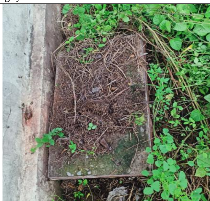
Hình 3.6. Hố ga đầu nối nước thải vào hệ thống thoát nước thải của KCN.
