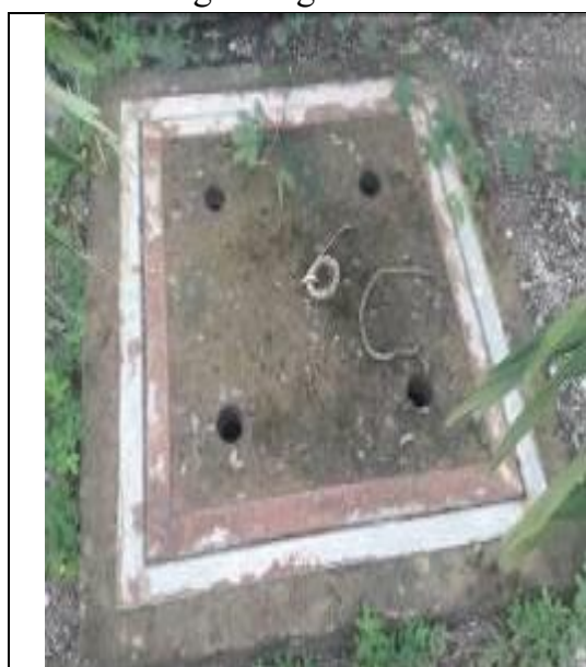
Hình 3.5. Hố ga thu gom nước thải Công ty.
