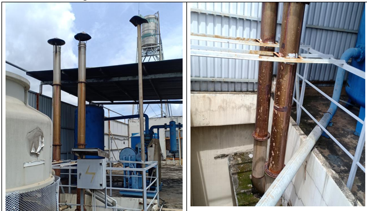
Hình 3.14. Hệ thống giảm thiểu khí thải máy phát điện dự phòng
