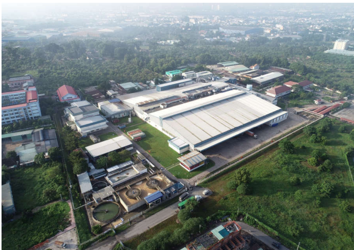
Hình 1. 1 Hình ảnh toàn bộ Nhà máy
