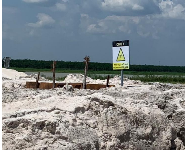
Hình 12. Hình ảnh hiện trạng các biển báo đã lắp đặt tại các vị trí
