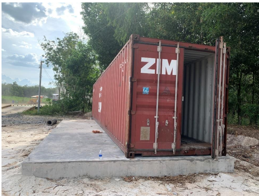
Hình 11: Hình ảnh hiện trạng Kho chứa tạm chất thải nguy hại
