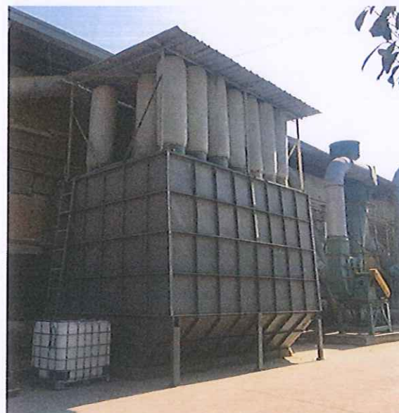
Hình 3.13. Hệ thống túi vải của nhà máy
