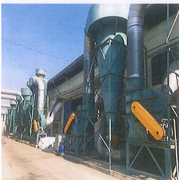
Hình 3.14. Hệ thống xử lý bụi tại khu tạo phôi và gia công tinh chế
