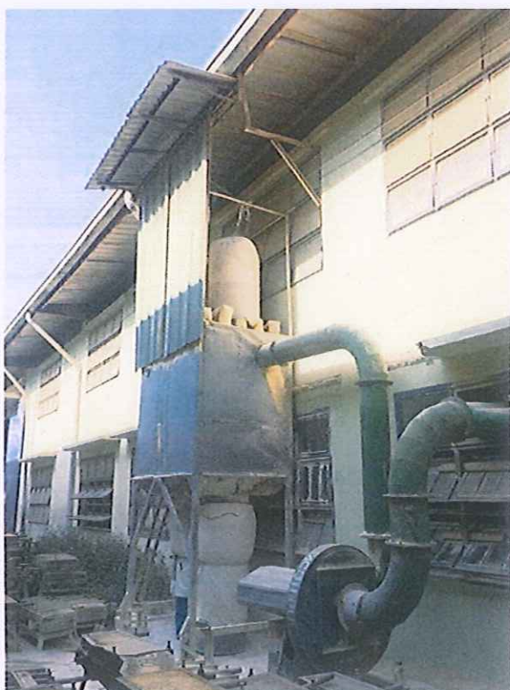
Hình 3.12. Hệ thống xử lý bụi chà nhám PU và khu vực gia công, tinh chế
