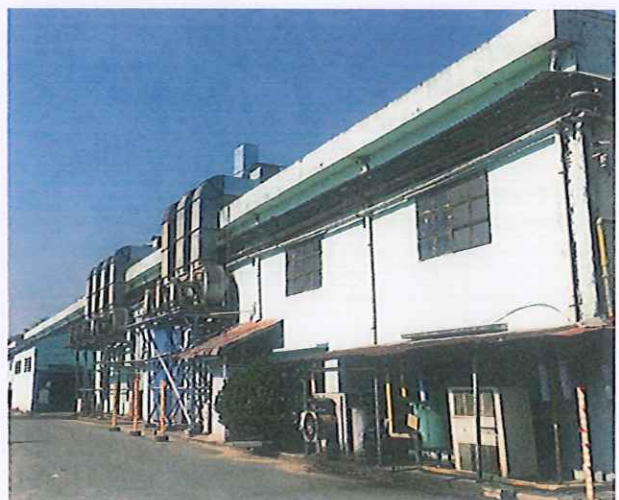
Hình 3. 16. Hệ thống xử lý hơi dung môi sau hệ thống sơn bằng màng nước
