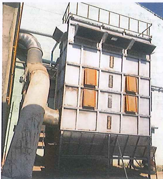
Hình 3.13. Hệ thống túi vải của nhà máy
