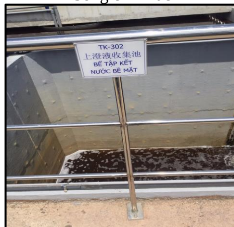
Bể tập kết nước bề mặt
