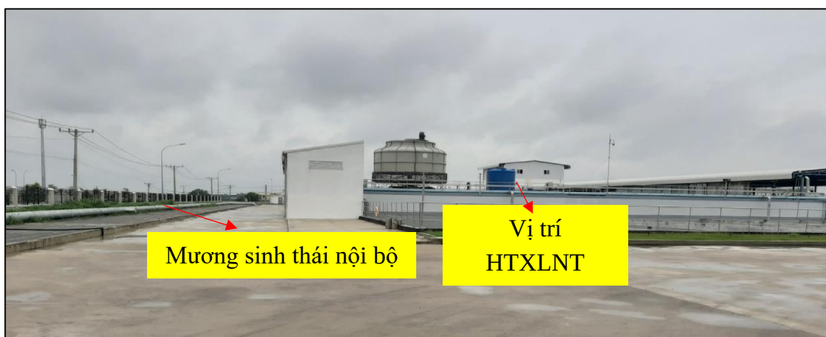
Hình 3.7 Trạm xử lý nước thải công suất 8.200 m 3 /ngày.đêm và mương sinh thái
