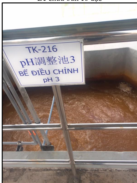
Bể điều chỉnh pH3
