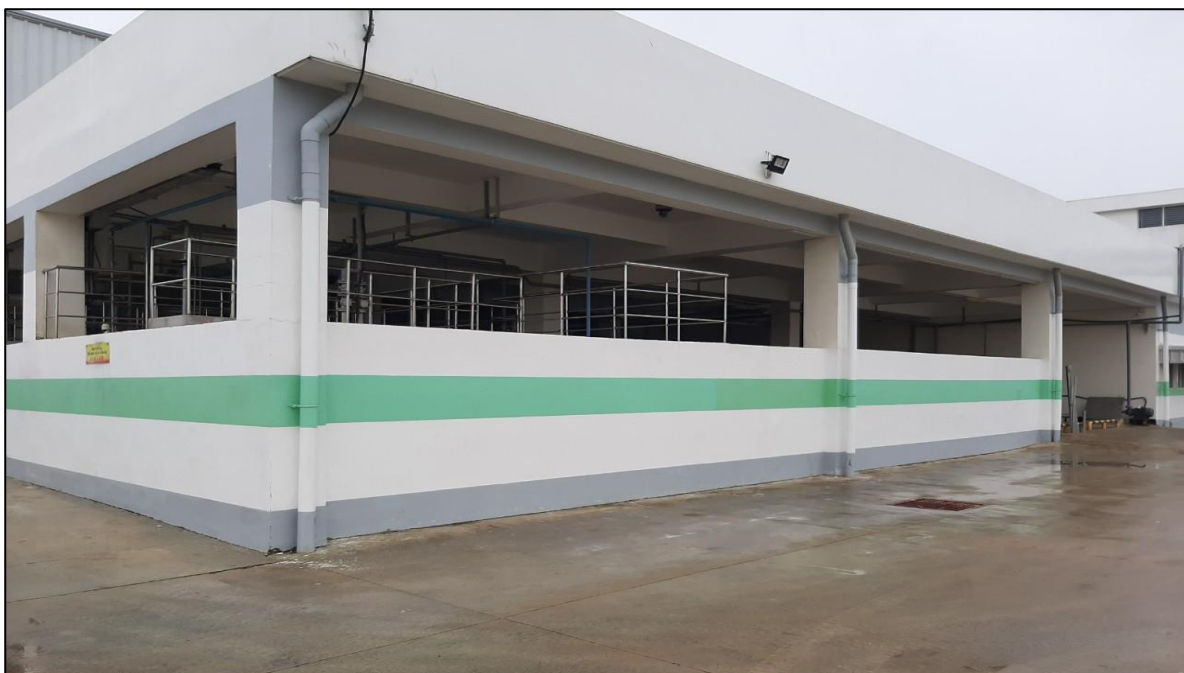
Hình 3.6 Hình ảnh trạm xử lý nước thải công suất 300m 3 /ngày.đêm
