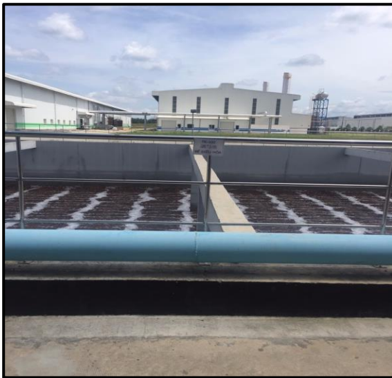
Bể điều hòa
