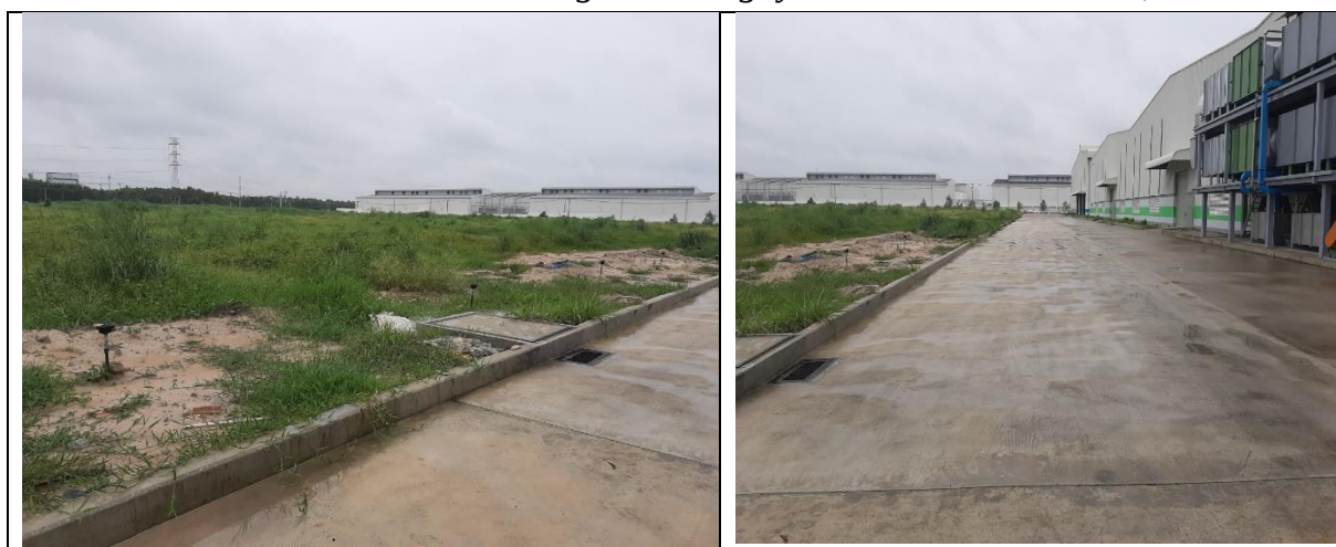
Hình 3.2 Hố ga thoát nước mưa trong khu vực nhà máy
