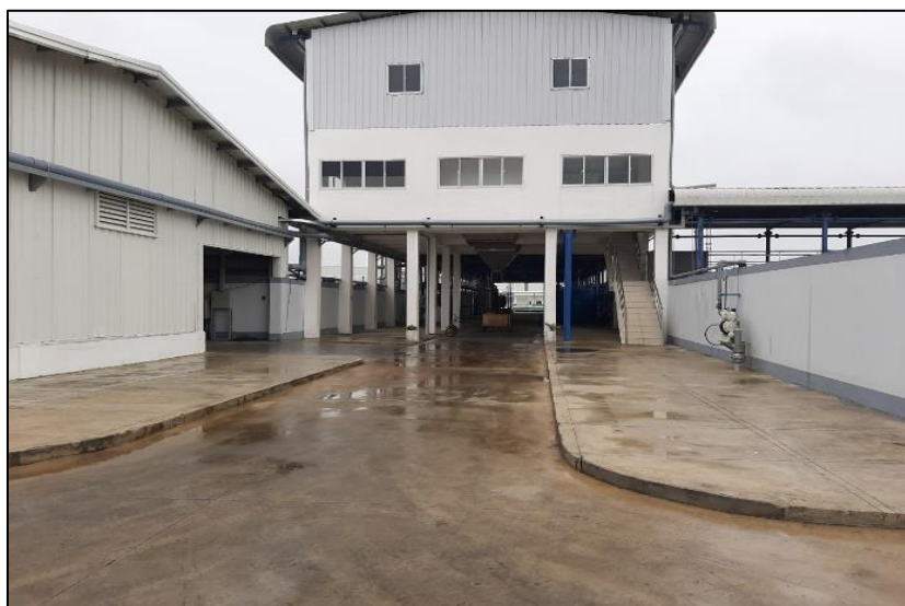
Hình 3.8 Nhà chứa máy ép bùn
