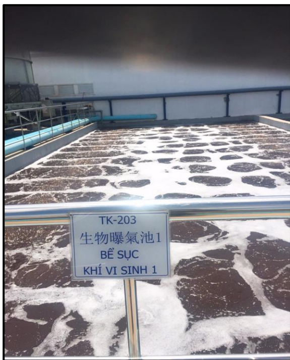
Bể sục khí vi sinh 1
