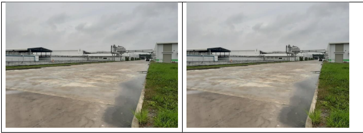
Hình 3.9 Nhà chứa máy ép bùn và Đường nội bộ khu vực HTXLNT
