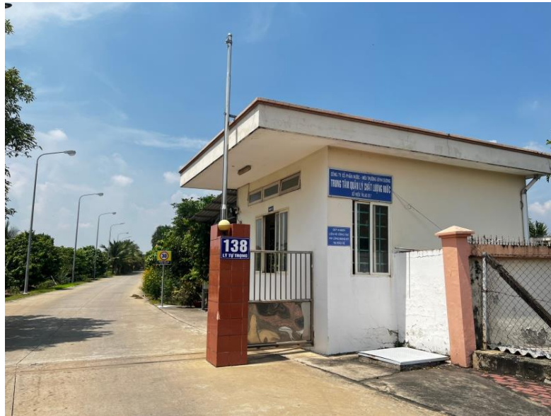
Hình 1.5. Khu nhà bảo vệ
