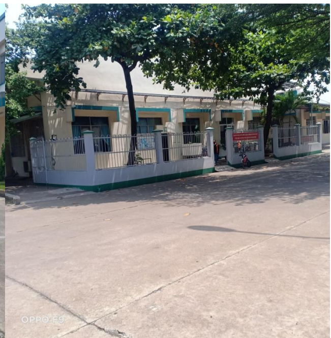
Nhà y tế và nhà công đoàn
