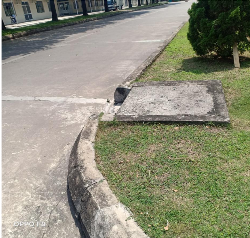
Hình 3.3. Cổng thu gom nước mưa trên trục đường chính
