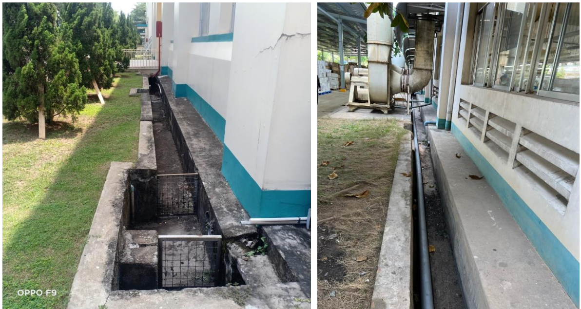
Hình 3.2. Mương thu gom nước mưa khu vực văn phòng và nhà xưởng
