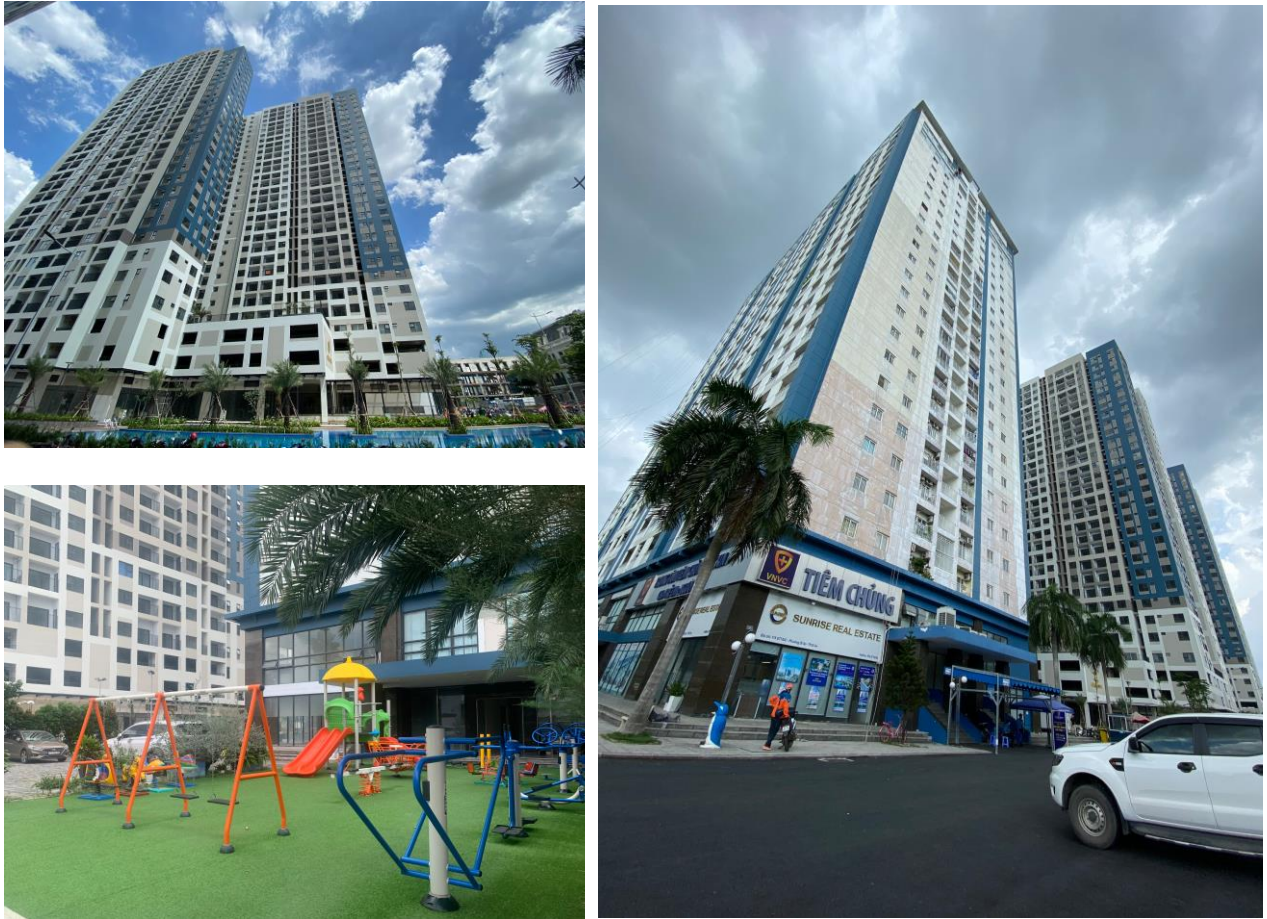
Hình 1.2. Hình ảnh hiện hữu tại cơ sở
