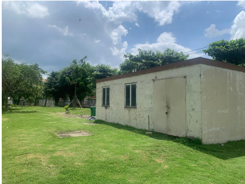
Hình 3.5: Khu vực hệ thống xử lý nước thải
