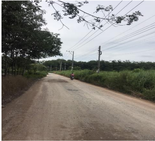
Hiện trạng đường Tân Hiệp 10
