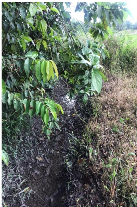
Hiện trạng mương thoát nước
