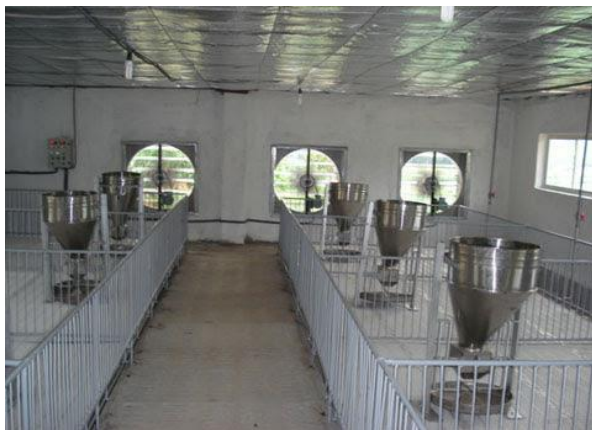
Hình 1.4. Hệ thống quạt hút và tấm làm mát
