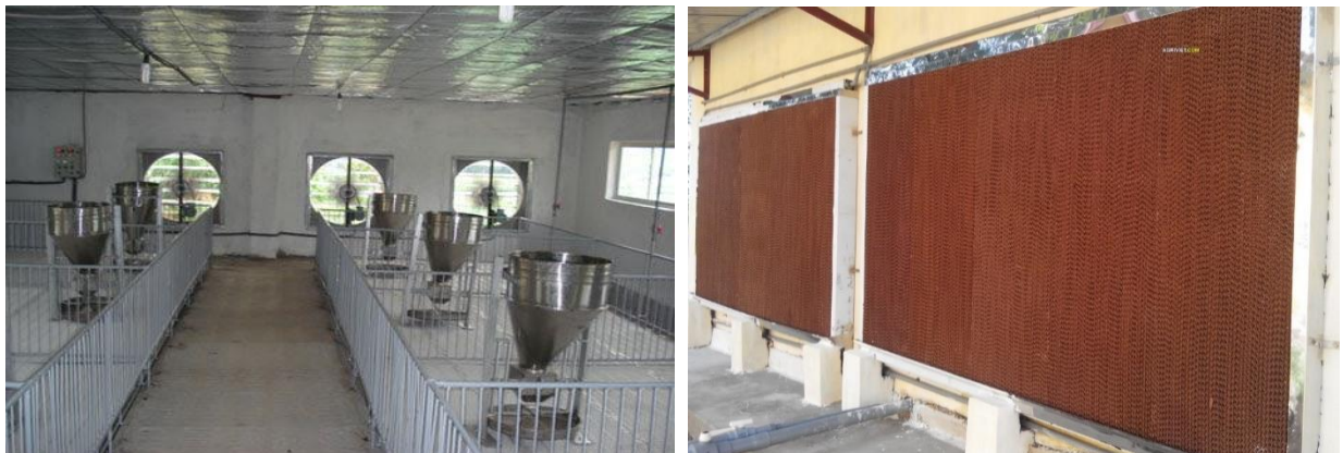
Hình 4.2. Hệ thống quạt hút và tấm làm mát
