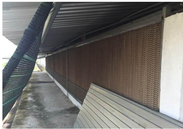
Hình 1.4. Hệ thống quạt hút và tấm làm mát
