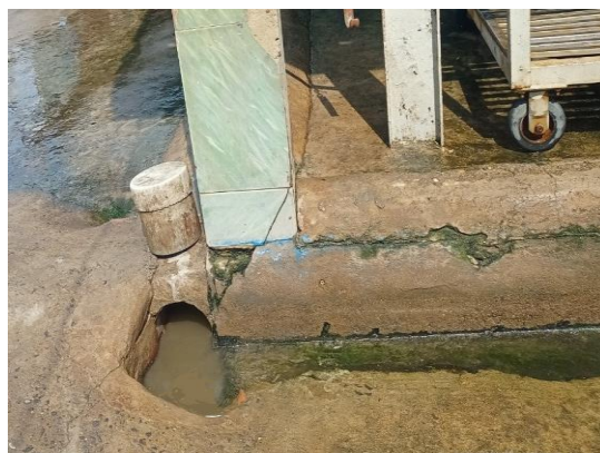
Hình 3. 3. Mương thoát nước mưa nội bộ
