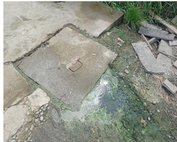
Hình 3. 7. Hố ga tập trung trước khi dẫn nước thải sản xuất về HTXL
