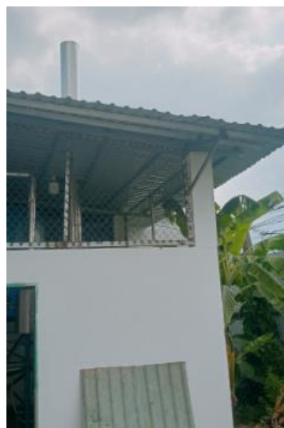
Hình 3.12. Ống khói phát thải lò hơi
