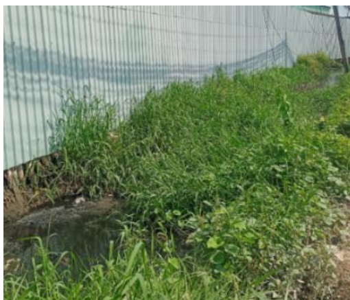
Hình 3. 4. Mương thoát nước của khu vực
