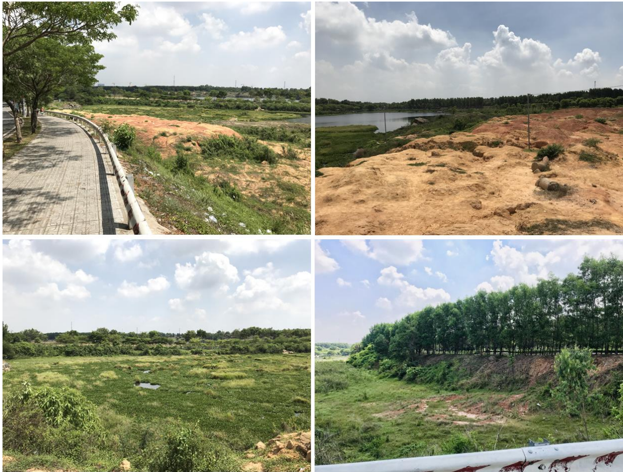
Hình 3.6 Hiện trạng khu vực thiết kế.
