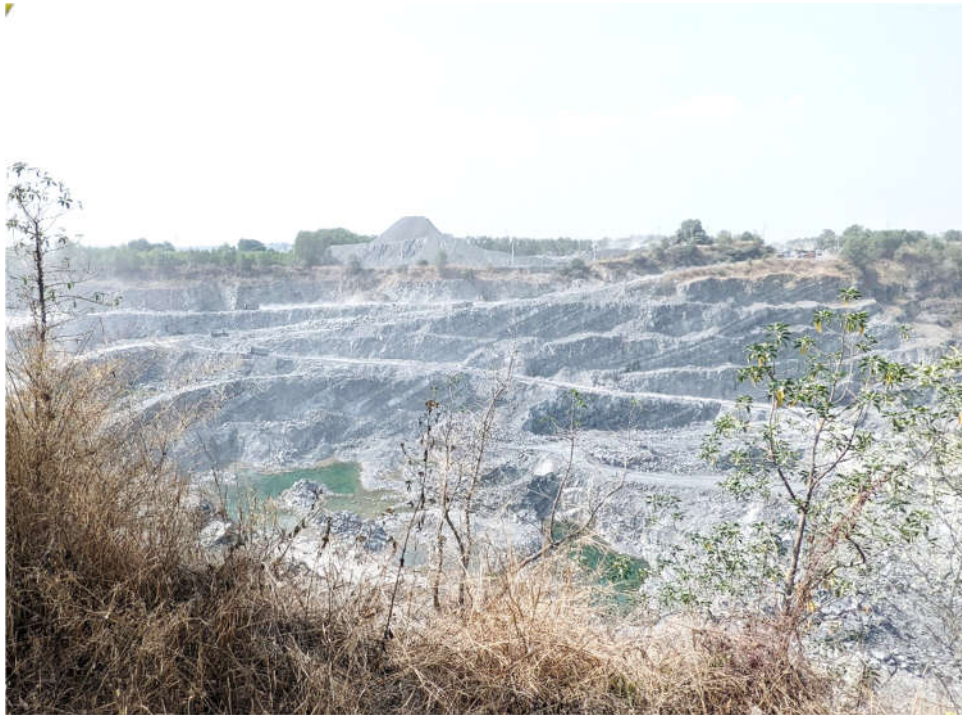
Hình 3.12: Mỏ đá xây dựng Thường Tân IV luôn thực hiện việc cắt tầng, tạo bậc theo đúng thiết kế để hạn chế các sự cố trong quá trình khai thác
