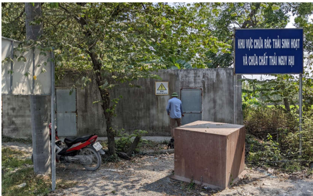
Hình 3.11: Nhà chứa chất thải nguy hại và chất thải sinh hoạt
