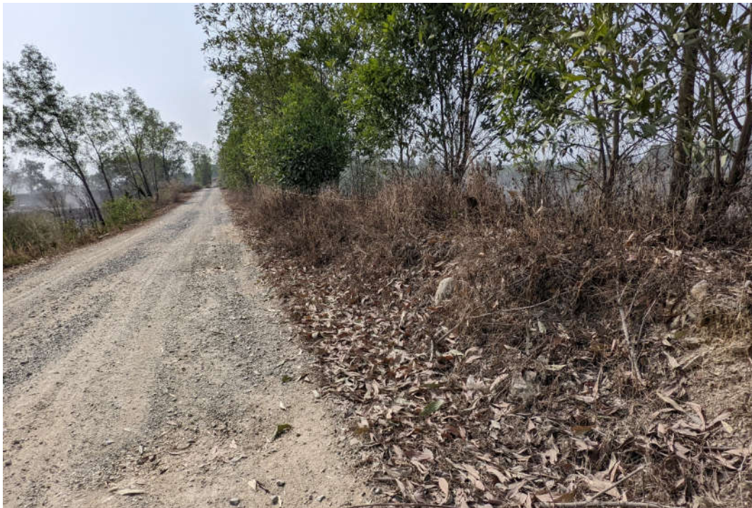
Hình 3.2: Tuyến đê xung quanh moong khai thác nhằm chặn nước mưa chảy vào moong
