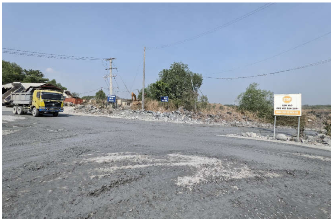
Hình 3.9: Các tuyến đường nội bộ mỏ được định kỳ tưới nước nhằm hạn chế phát tán bụi trong những ngày trời nắng to
