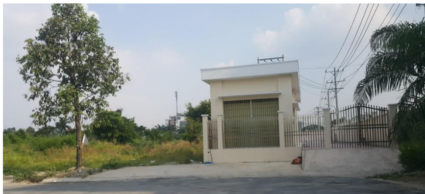
Hình 3. 4. Trạm bơm trung chuyển nước thải P1-2 của khu vực (Bản vẽ hệ thống thu gom và thoát nước thải đính kèm tại phụ lục báo cáo)
