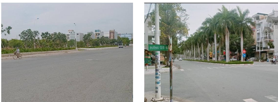
Hình 1. 8. Đường giao thông nội bộ tại khu vực dự án
