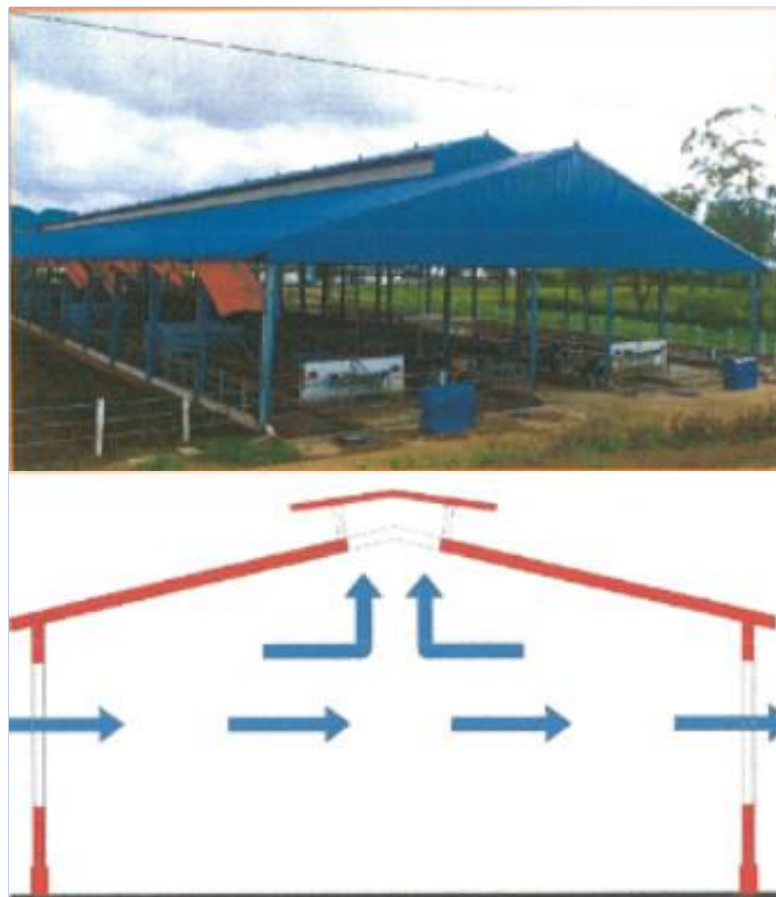
Hình 1.6. Hình ảnh kết cấu khung, mái chuồng trại
