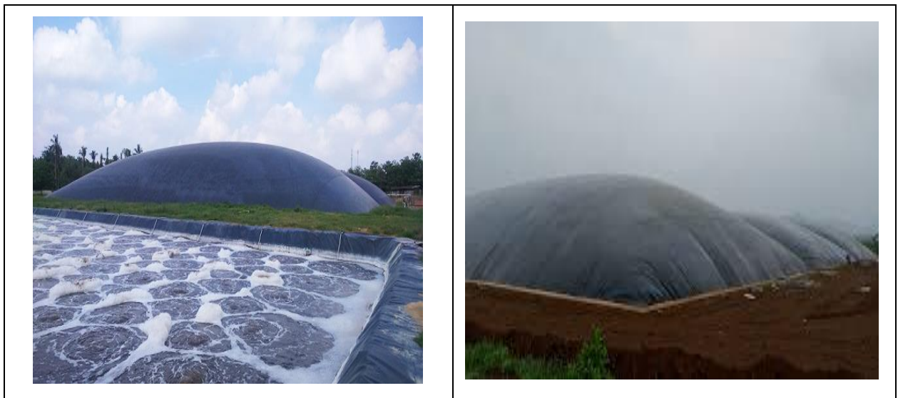
Hình 3. 5. Hình ảnh Hầm Biogas
